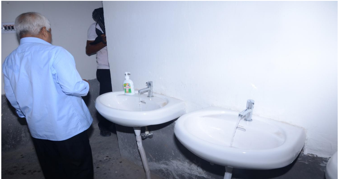
Girls Toilet Room
